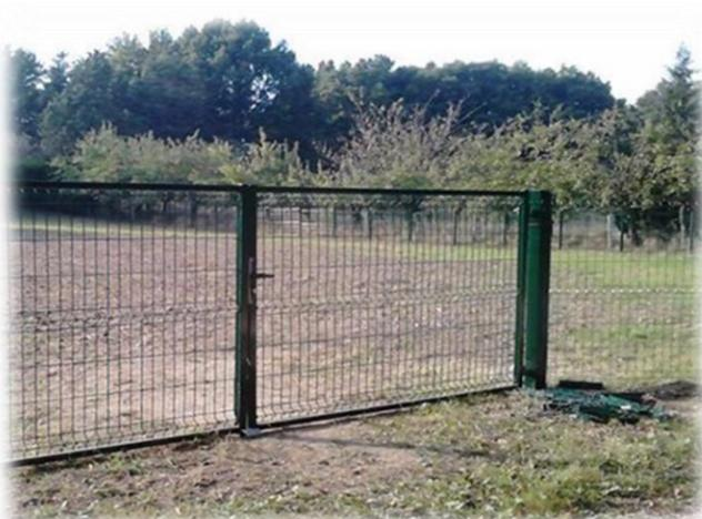
Un portail sécurisé, à deux battants ouvrant vers l'extérieur sera mis en place. Il sera en acier galvanisé et équipé d'un grillage anti-escalade soudé et thermolaqué.
